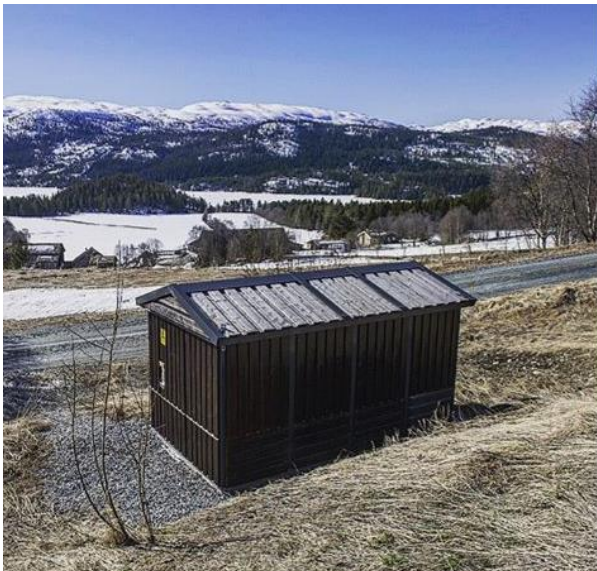
Fig. 8 .Eksempel på 22 kV prefabrikkert nettkiosk (her ABB)
