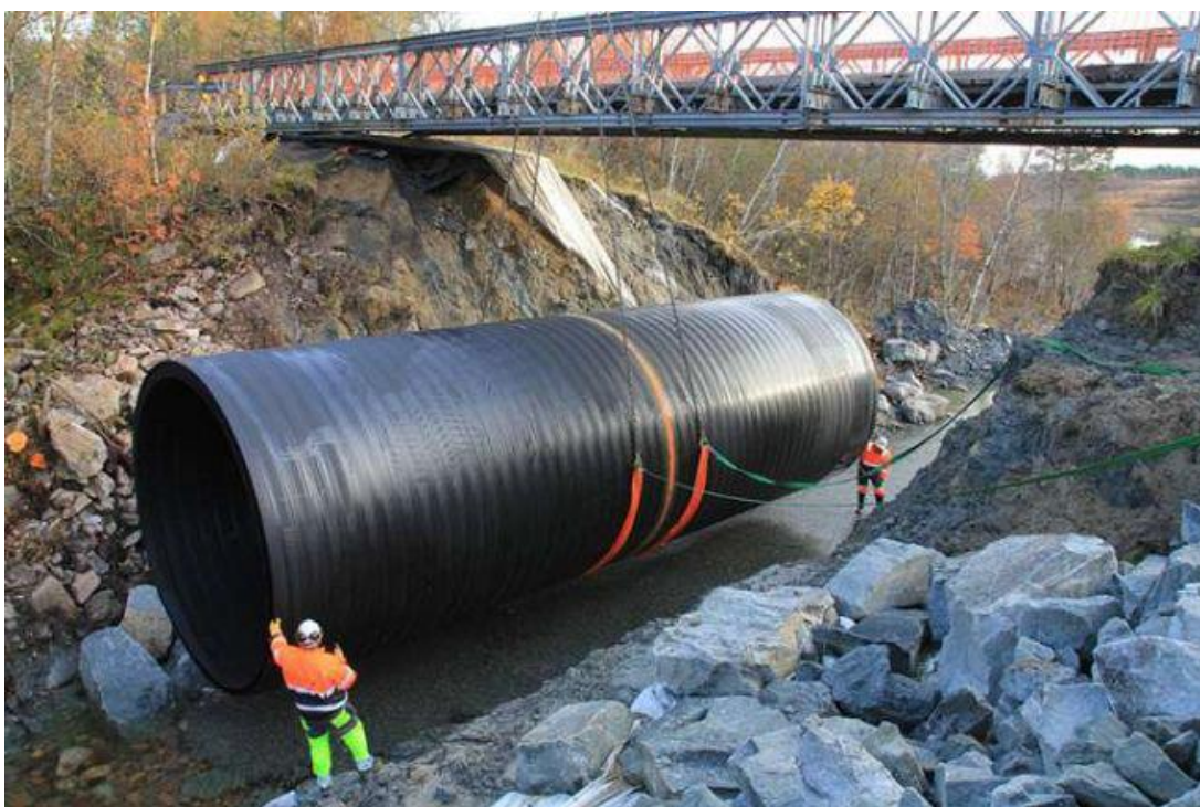
Figur 3: PE-kulvert (rør i fylling): Fv. 711 Breivika
