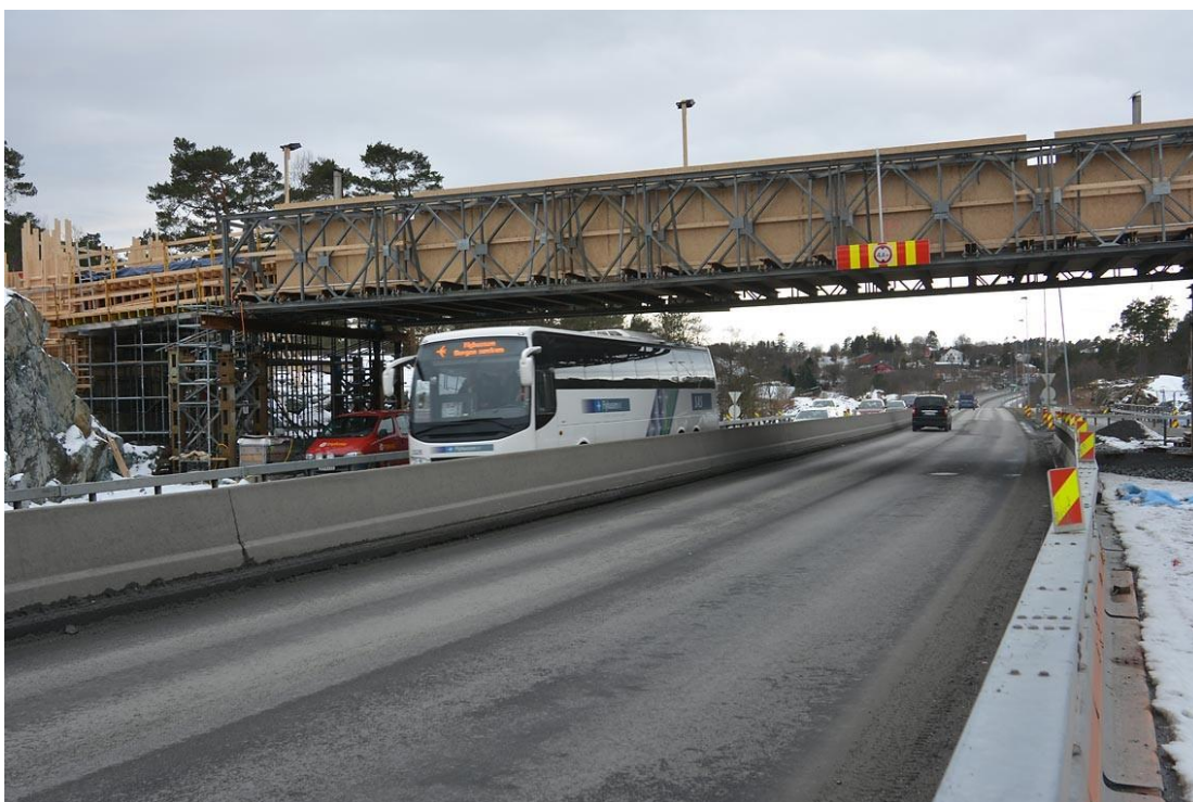
Figur 4: Gang og sykkelvegbru: Skeivatn RV. 580 Flyplassvegen
