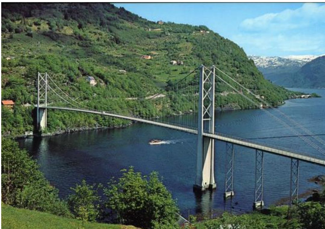
Figur 1: Vegbru: Hengebru over Fykesundet på Fv. 7 mellom Øystese og Ålvik i Kvam herad
