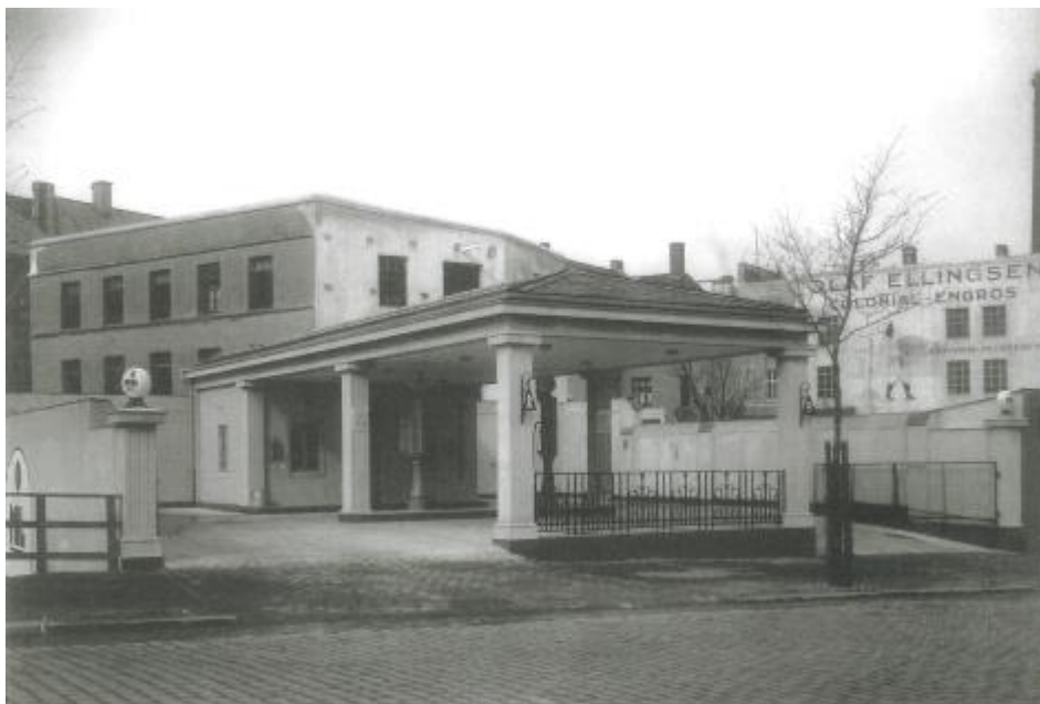
Bensinstasjonen som ny i slutten av 1920-åra. Foto utlånt av Museumsgruppen i Statoil Norge og Statoil detaljhandel AS
