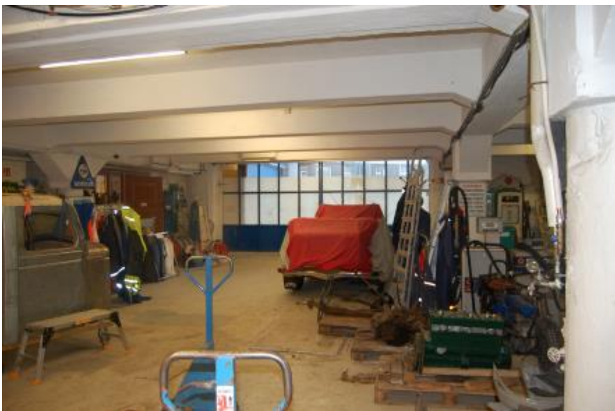
Underetasjen sett mot vest. Midt i bildet smøregraven i golvet
