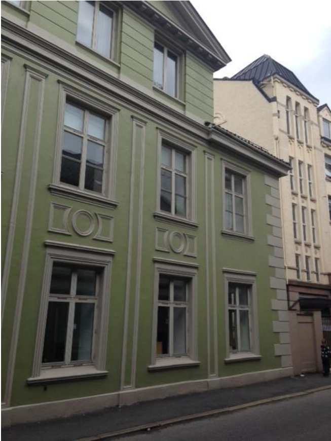
Fasaden mot Kong Oscarsgate etter restaureringen.
