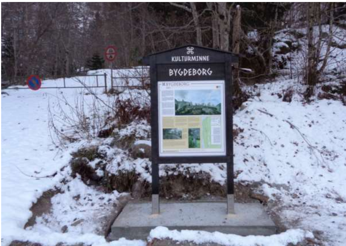
Skiltet ved parkeringsplassen. Betongplattformen blir gravd ned, slik at skiltet er tilgjengelig fra rullestol..
