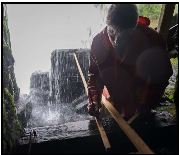
Oppmåling av avstand mellom opplagerne.
