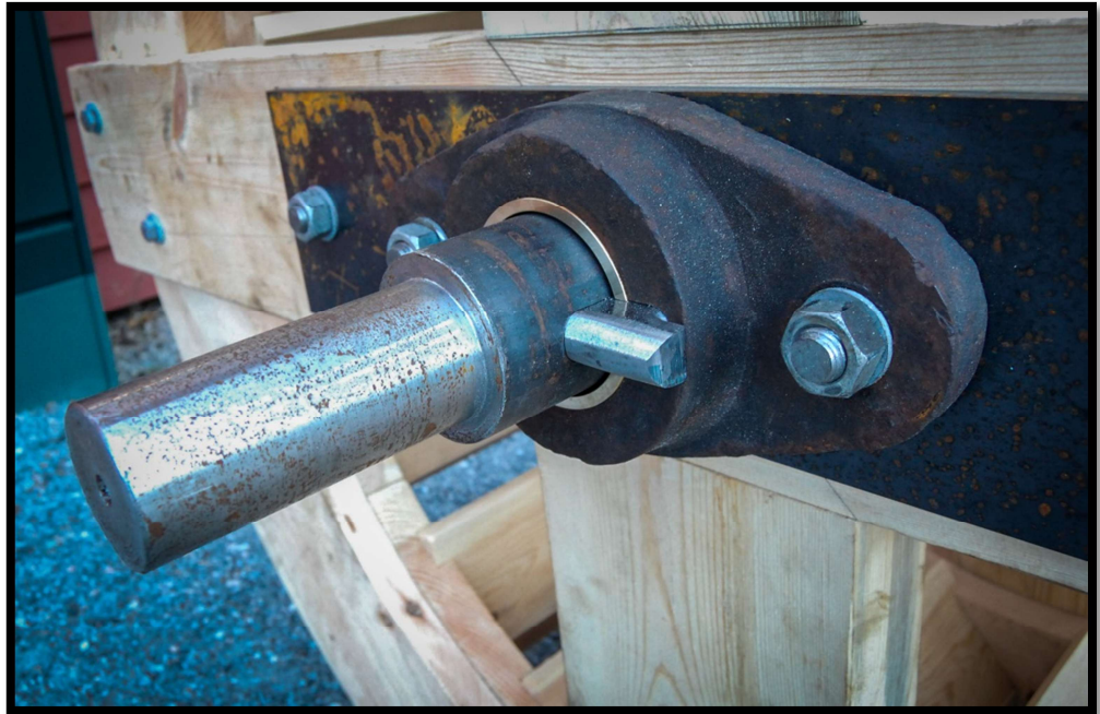
Ny aksling med kile og renoverert flens.
