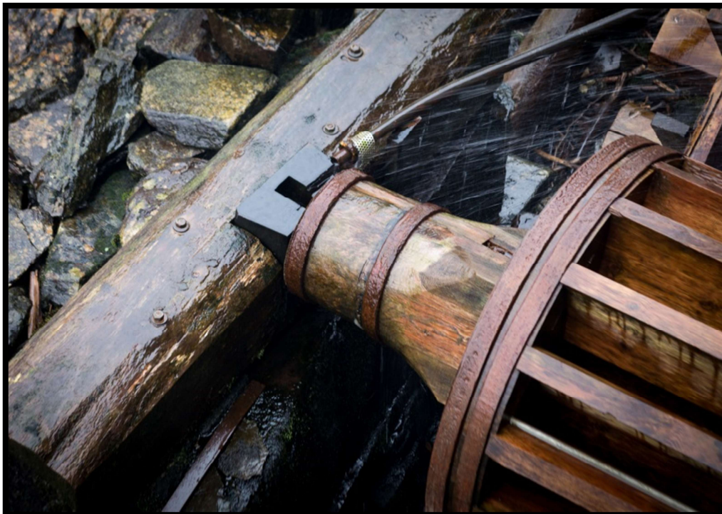
Pukkenholtlager på hovedhjulet. Slange for vannkjølingen ses øverst i bildet.
