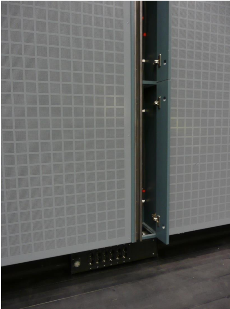
Figur D.4.1.6 Exempel på ankarskinne og uttagsenhet
