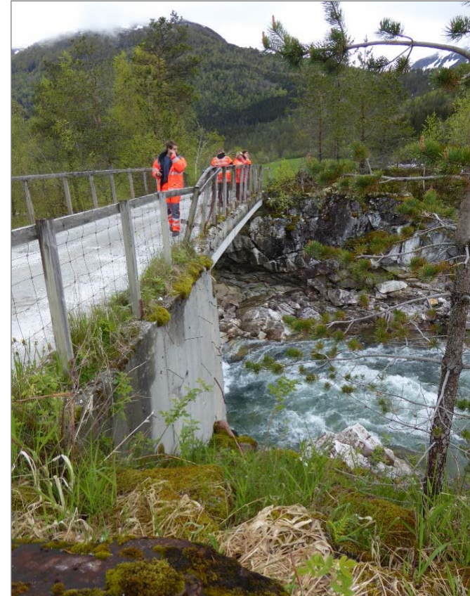
Eksisterande bru over Ljoselvi. Brua er tilkomst til landbruks-områda på vestsida av elvi, og der ny tunnel er planlagt. Foto, Eli Mundhjeld.
