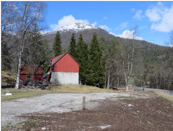
Garasjen til gbnr 331/5 ved eksisterande veg må fjernast fordi arealet skal utformast slik at det vert sikt langs vegen. Foto, Ingar Hals
