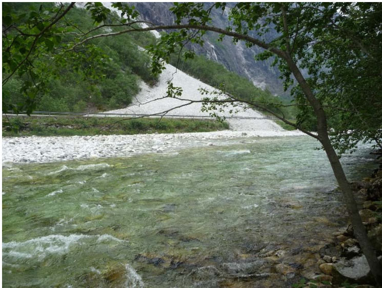
Skred i Nærøydalen. Ny tunnel rassikrar området. Foto Eli Mundhjeld.
