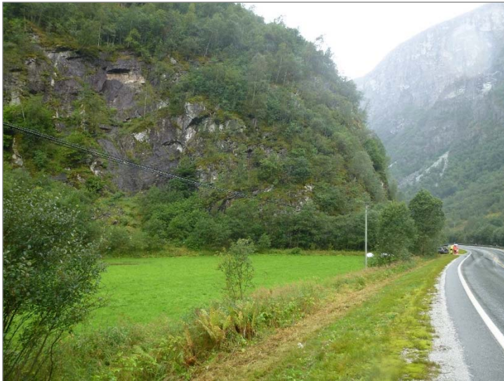
Ved Hylland går tunnelen inn i bergveggen i bakkant av jordet. Høgda på bergveggen gir god overdekning til tunnelen. Foto, Synnøve Stalheim
