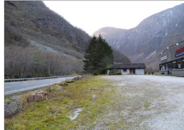
Det mindre bygget på næringsområdet til gbnr. 60/14, ligg i trase for ny veg og må rivast. Foto, Ingar Hals
