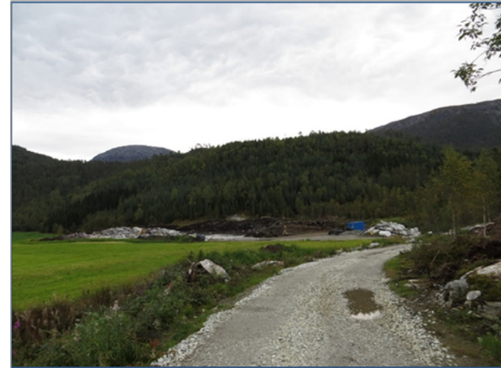
Ved Slæn går tunnelen inn i den skogkledde åsen under Høgrusti. Det slake terrenget gir lang open skjering før tunnelen får overdekning av fjell. Foto, Ingar Hals
