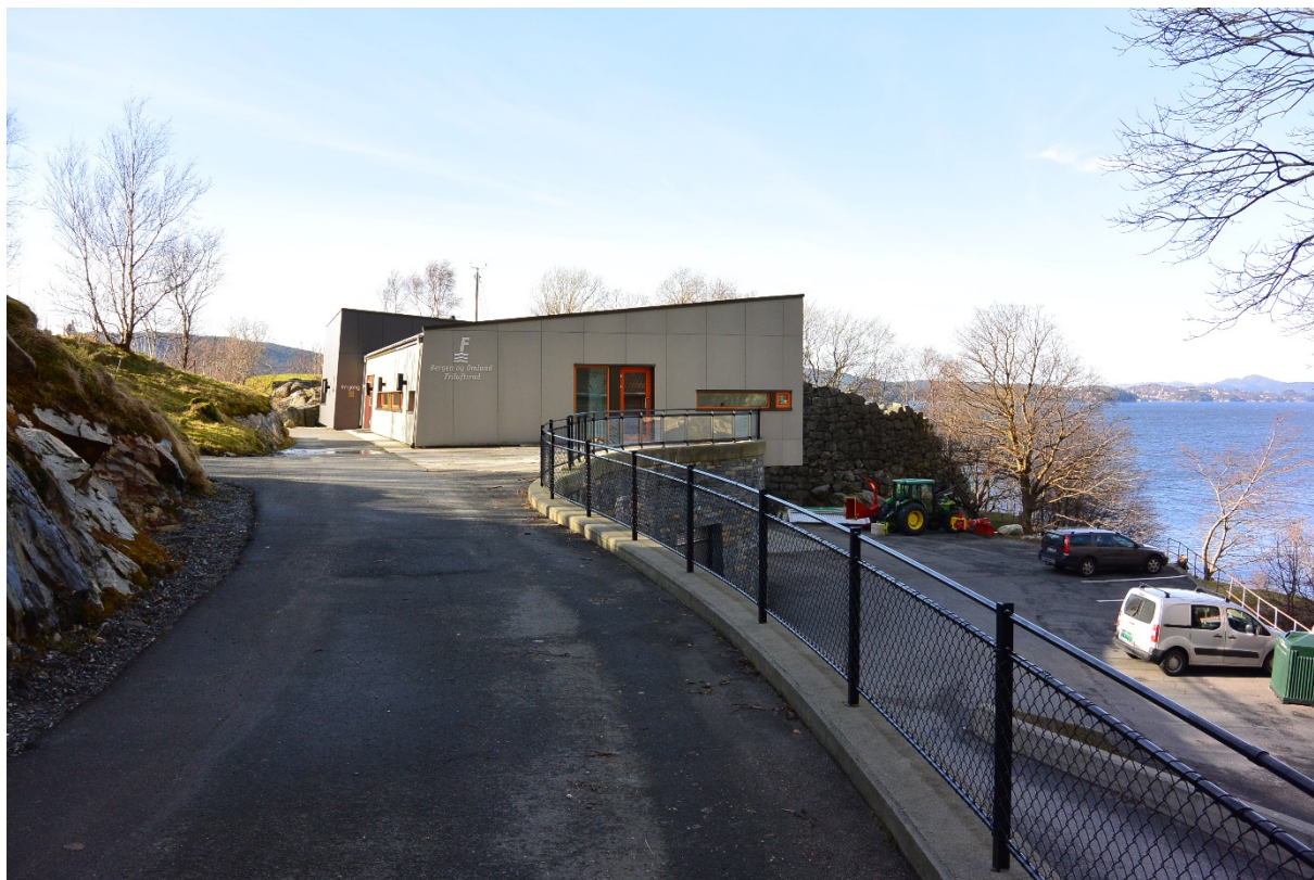
Bilde 3: Kontorbygg til Bergen og Omland Friluftsråd (BOF) med garasje i kjelleren.
