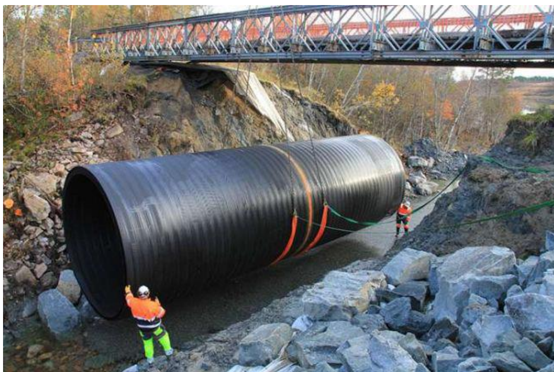
Figur 3: PE-kulvert (rør i fylling): Fv. 711 Breivika
