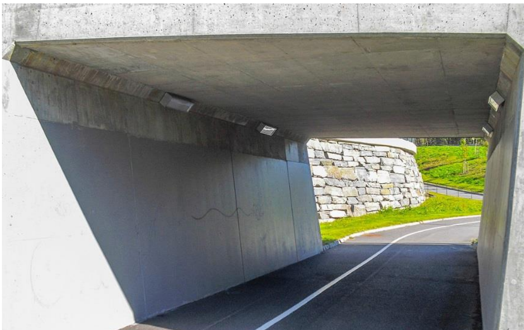
Figur 2: Kulvert/ Bru i Fylling: Fv. 556 Søreide
