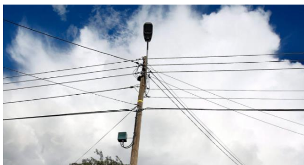
Figur 8: Eksempel på stolpe med fellesføring. Forkortelsen NS i illustrasjonen står for Nettstasjon
