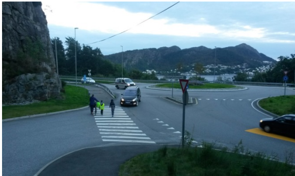
Bilder før utbedring
