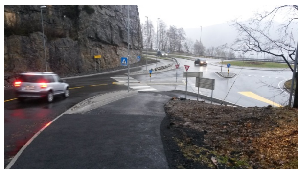
Bilder etter utbedring
