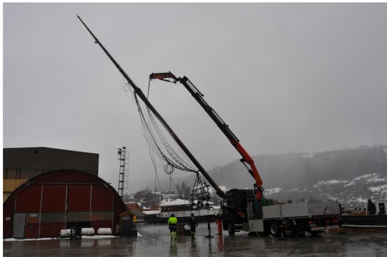
Midtre del av masta vart skifta ut (sjå eigen rapport). Alle antenner og kablar i masta måtte demonterast og vart montert opp på nytt.
