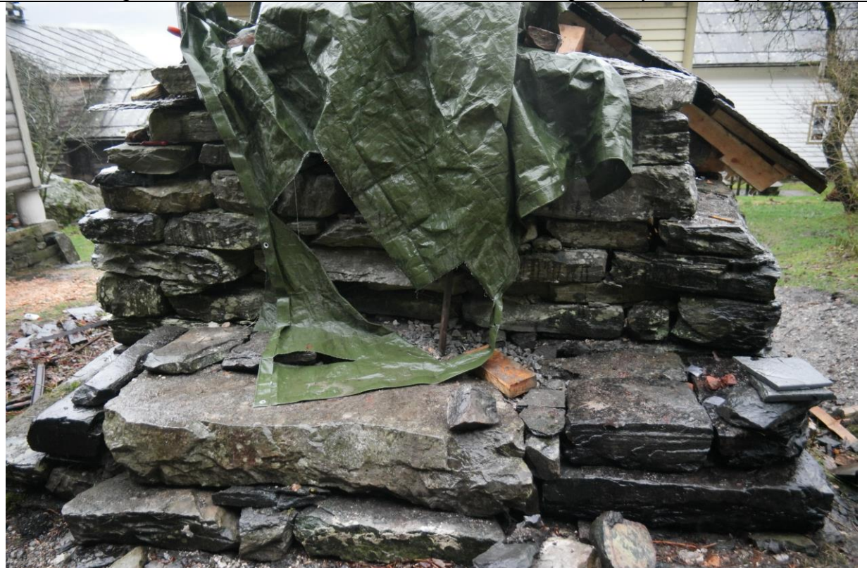
Foto over og under viser mur under arbeid. Stein som låg i ei røys vart lagt på plass.
