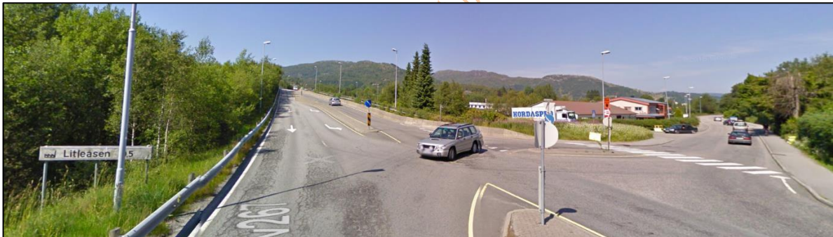
Figur 23 Fullkanalisert T-kryss ved Litleåsveien
