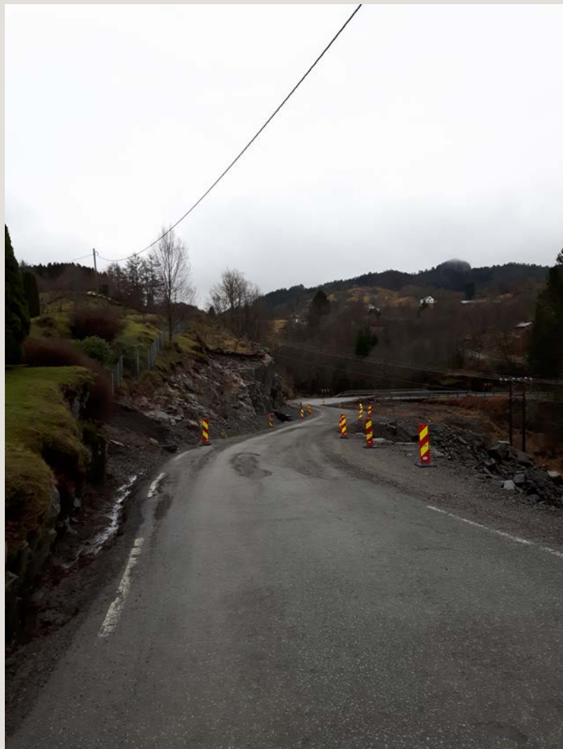
Bilete frå anlegget før asfalt, autovern og vegmerking:
