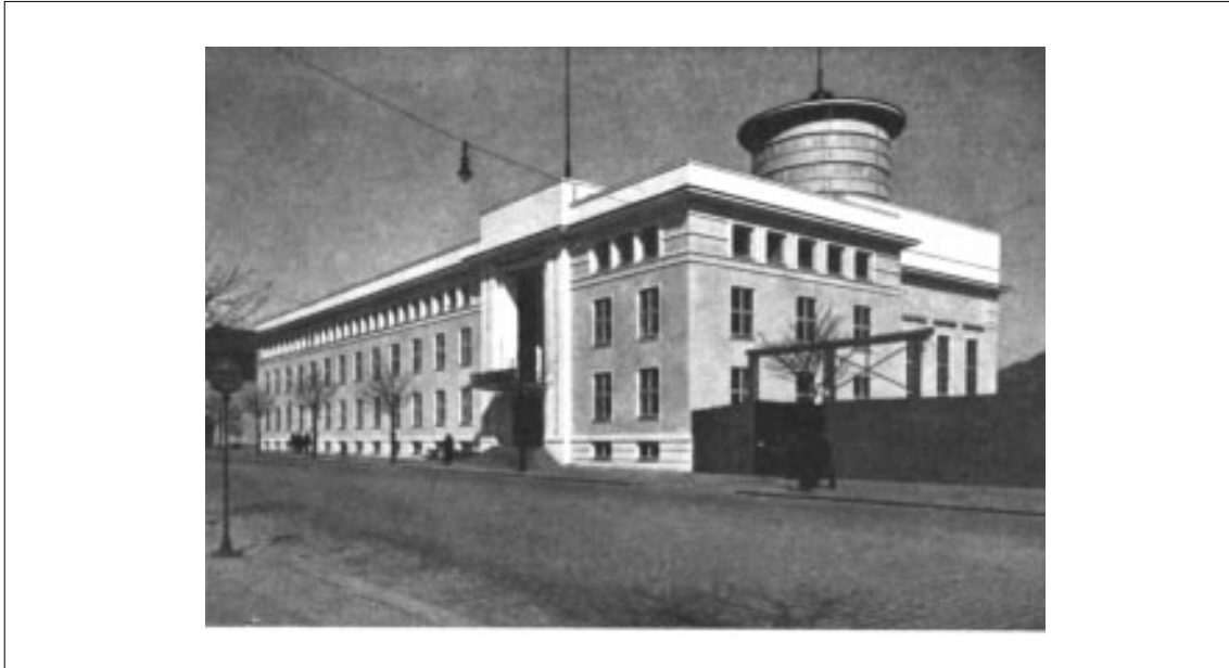
Fig. 19: Bergens Lysverker, Fasade mot Lars Hillesgt.
