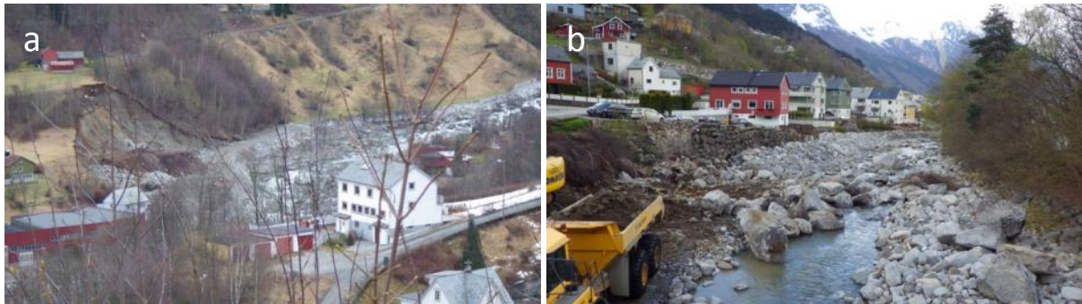
Figur 3.4. Bileta syner erosjonsskadar (a) og plastring (a og b) av elvebreidda etter storflaumen i Opo, oktober 2014.
