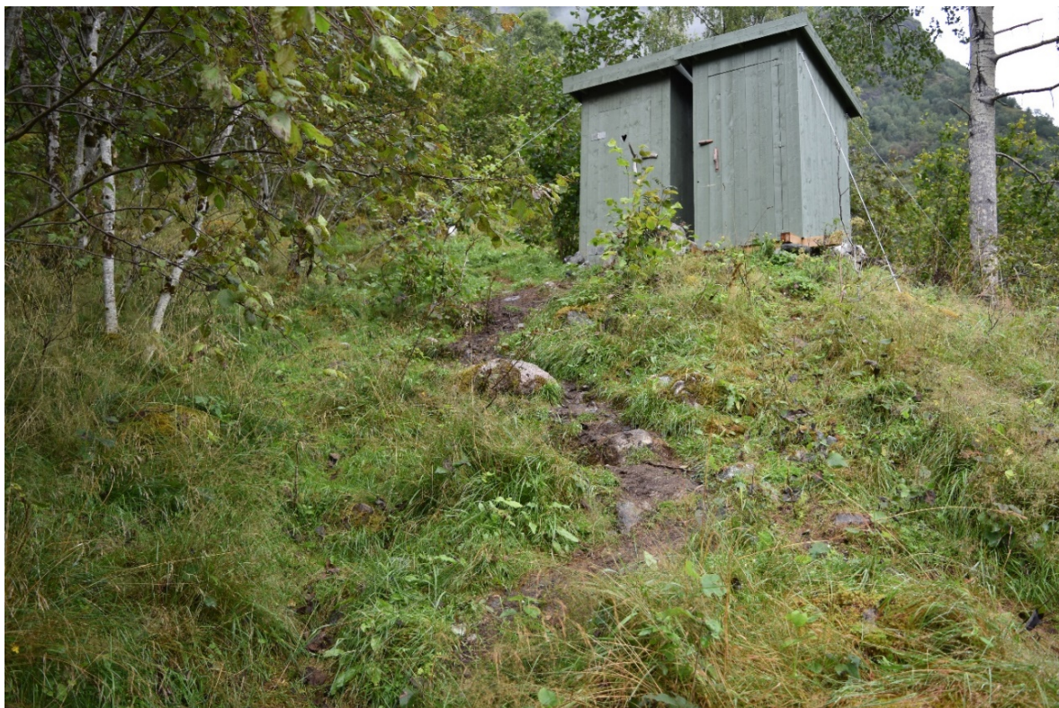
Figur 9. På eit par av dellokalitetane er det sett opp toalettfasilitetar eit stykke unna sjølve landingsplassen. Ved Salthella er huset plassert slik at ein må gå opp ei bratt skråning. Ved auka ferdsel kan det bli meir slitasje her og behov for å forsterke stien med stein eller trapper.
