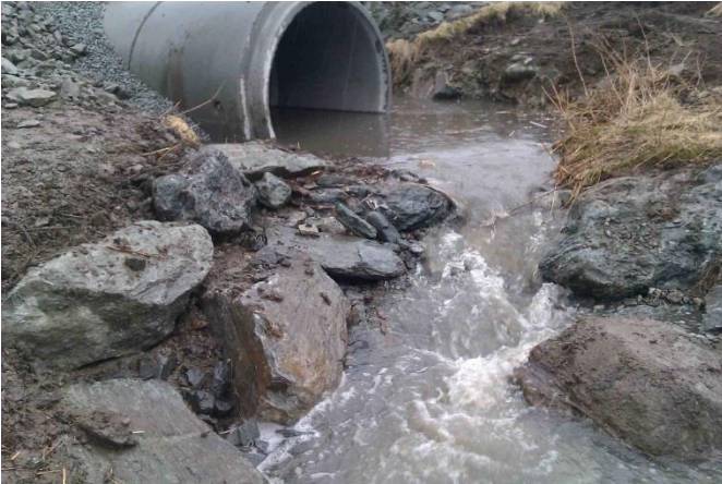
Ny turvei over Sakkestadbekken i Haugesund kommune. Kulvert med utløpskulp og fri passasje for fisk opp og inn i kulp.
