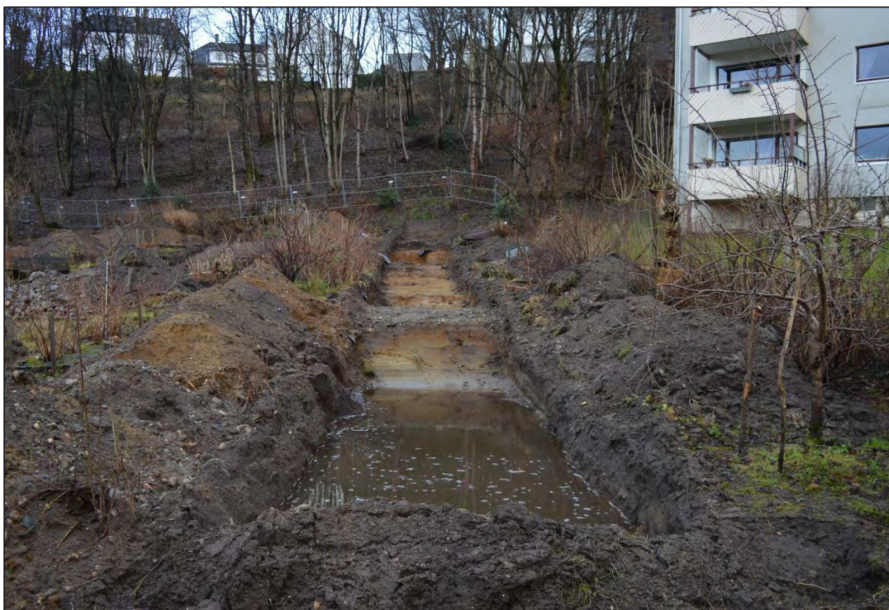
Figur 51. Sjakt 9 mot aust
