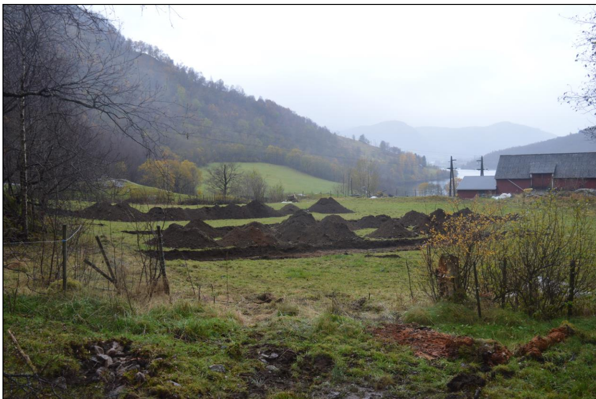
Figur 15 Sjaktene 9, 8, 7 (forgrunn til bakgrunn). Sett mot sørvest
