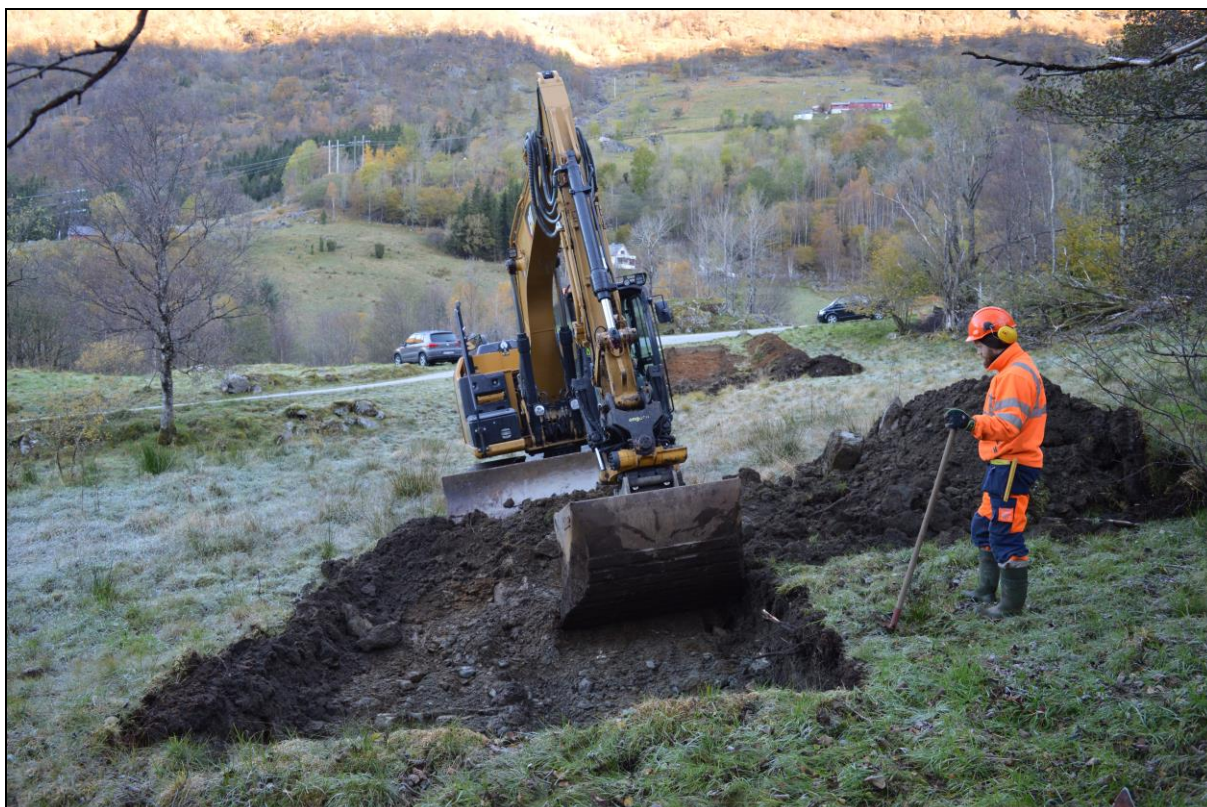
Figur 13 Graving av sjakt 2. Sjakt 1 i bakgrunnen. Sett mot nord
