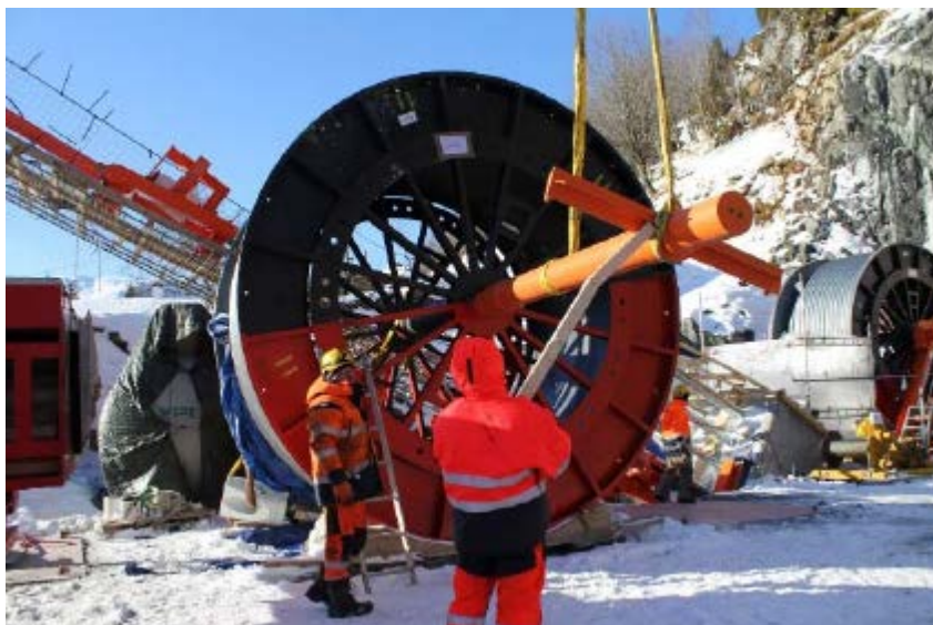
Figur 3 Trommel med bærekabel (Dalsfjordbrua)
