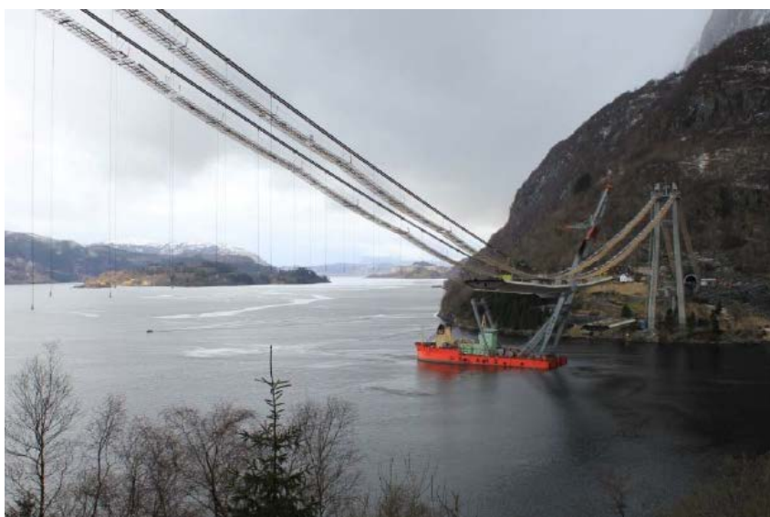
Figur 4 Montering av avstivningsbærer (Dalsfjordbrua)
