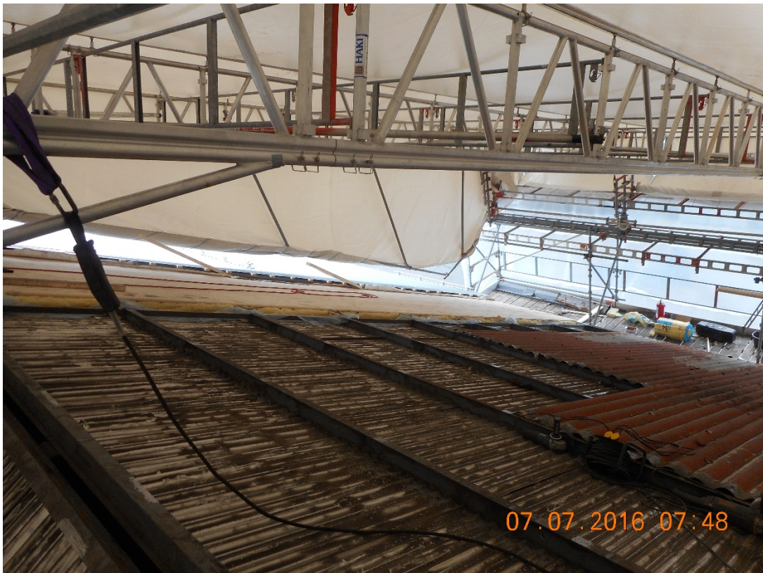
Døme på dokumentasjonsfoto frå entreprenøren. Innvendig himling vart liggjande urørt.
