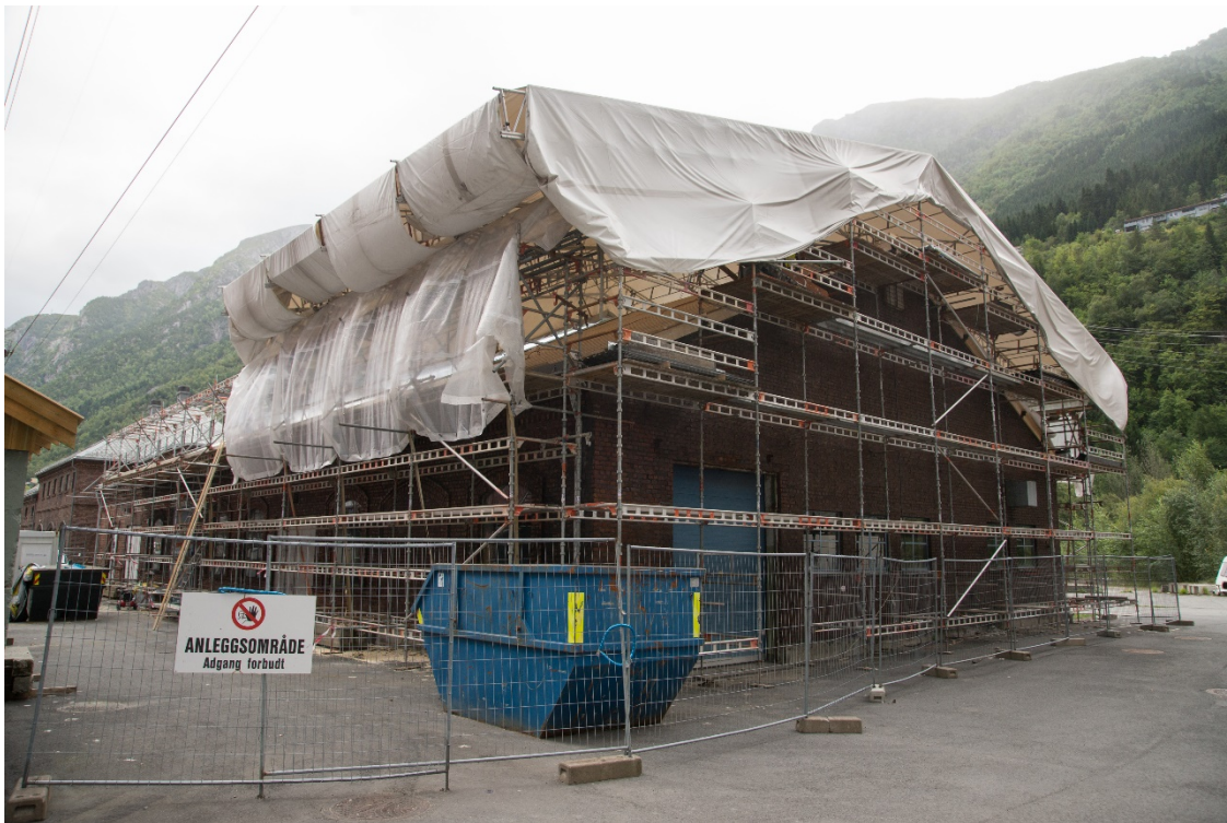
Stilas, tak over tak og sikring av anleggsområde.
