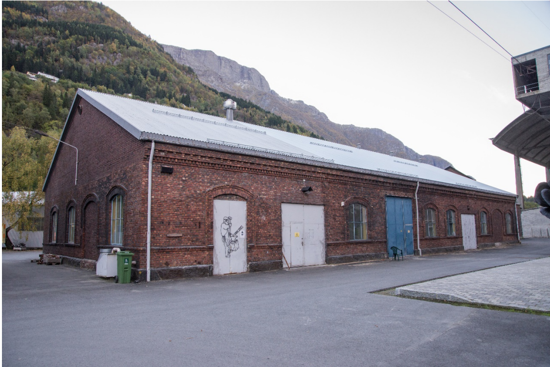
Ferdig mot vest
