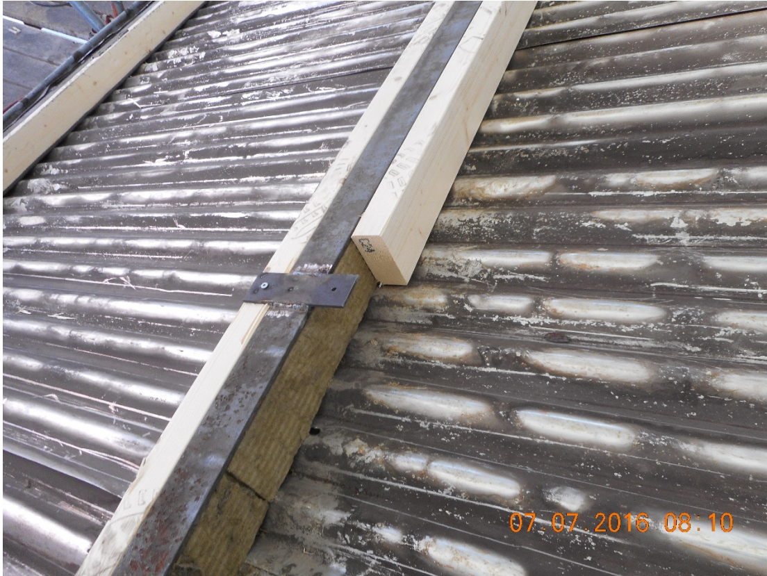
Dokumentasjonsfoto frå entreprenøren. Isolering i steg for å hindra kuldebru og innfesting av spikerslag.
