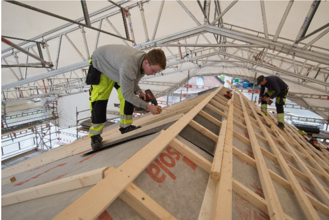
Arbeidsmiljøet under gjennomføringa og sikring av bygget og gjenstandar mot regn.
