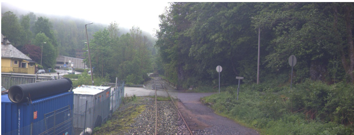
Figur 6 Dyngelandsveien planovergang i retning mot Oslo
