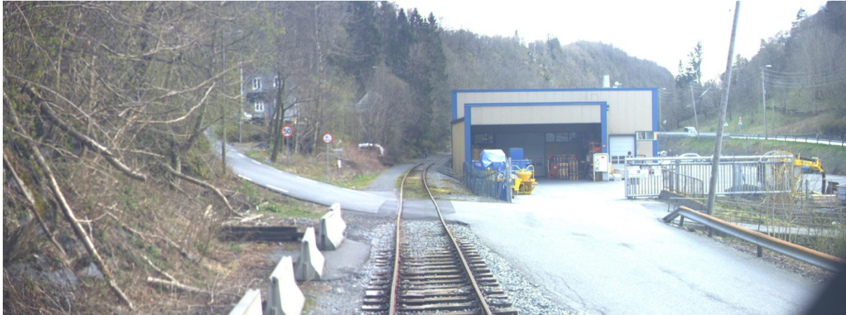
Figur 7 Dyngelandsveien planovergang i retning fra Oslo
