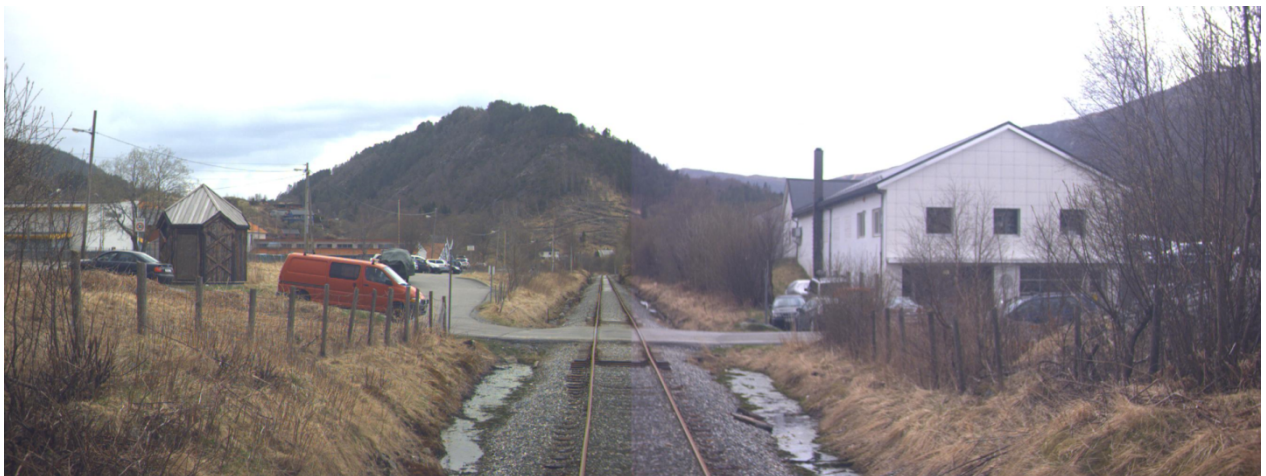
Figur 4 Lone planovergang i retning mot Oslo
