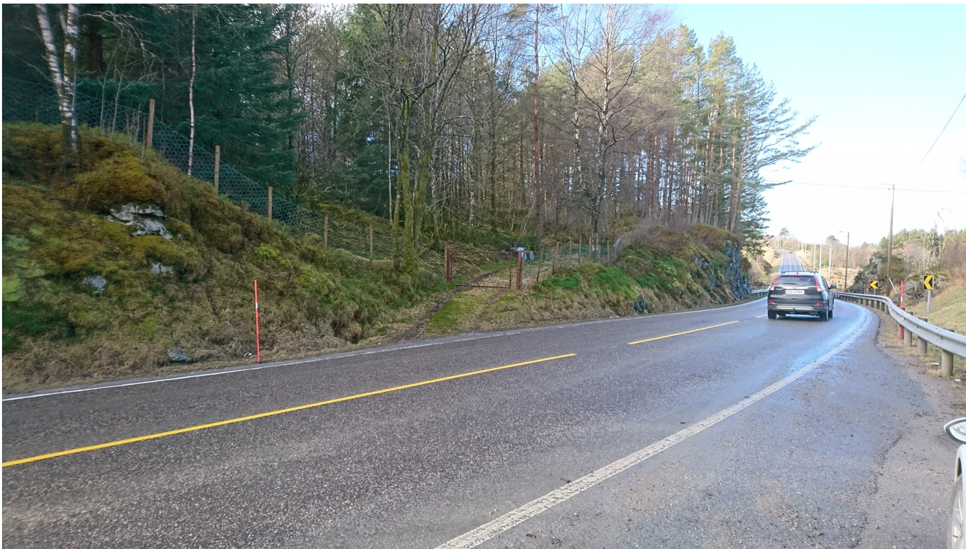
Noverande avkjørsle frå gbnr 74/17 i Radøy kommune til Fylkesveg 565, sett frå søraust på langt hald.
