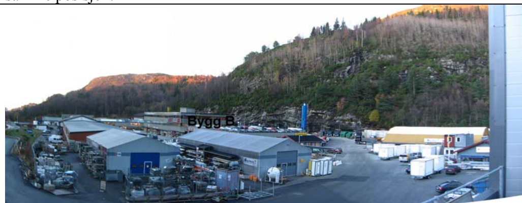
Figur 7. Oversikt fjellside langs Bygg B og noe lengre øst. Fjellskjæringen ses som tilnærmet loddrett del fra adkomstveien og oppover til vegetasjonsdekket skråning. Høyere opp ses blottlagt berg, hvorav noen områder må betraktes som potensielle løsneområder for steinsprang.
