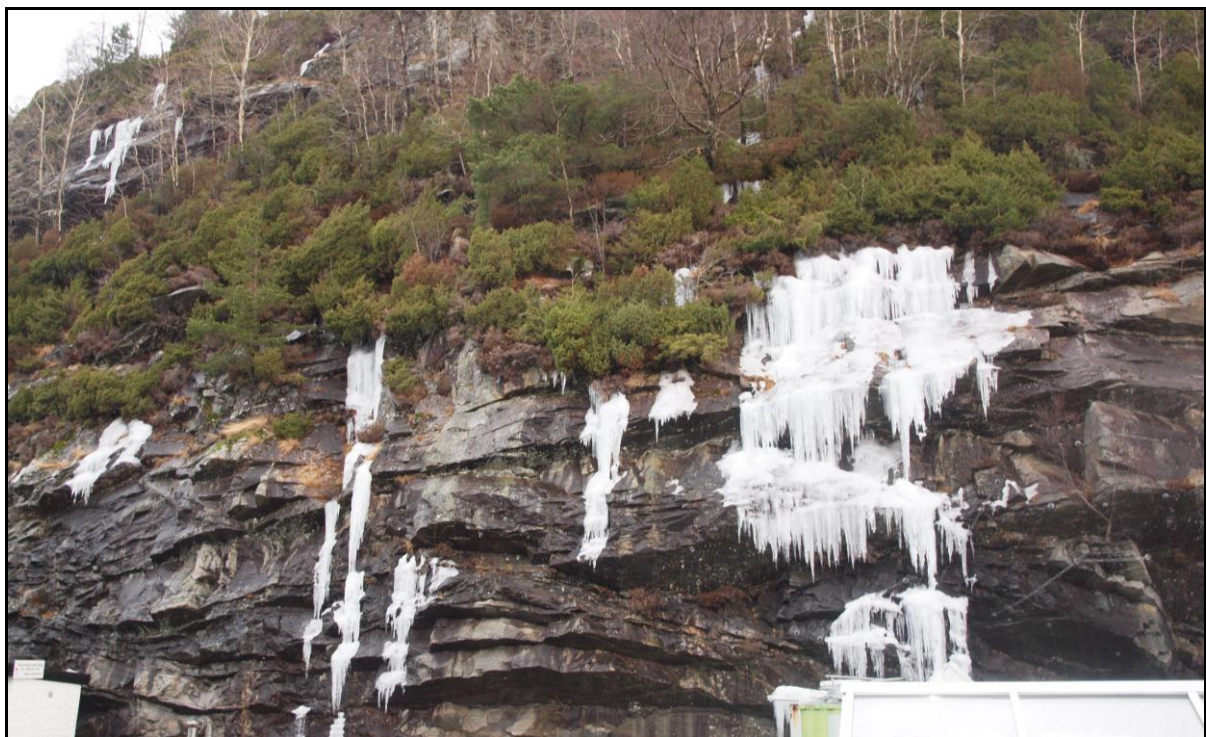
Fig 6. Drenering er lokalt fra skrenten, men kan medføre en del isdannelser.
