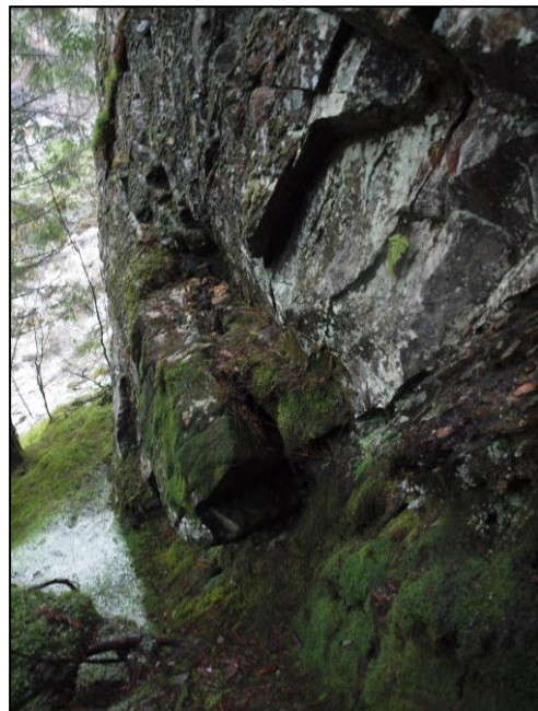
Fig. 16. Skrent må boltes.
