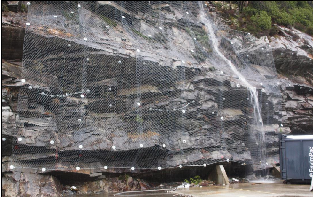
Fig 14. Sikret område nordøst for bygningsmasse.
