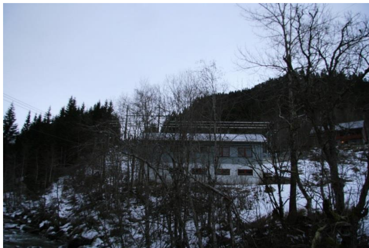
Figur 1 Eksisterende Trafostasjon ca. 313 moh
