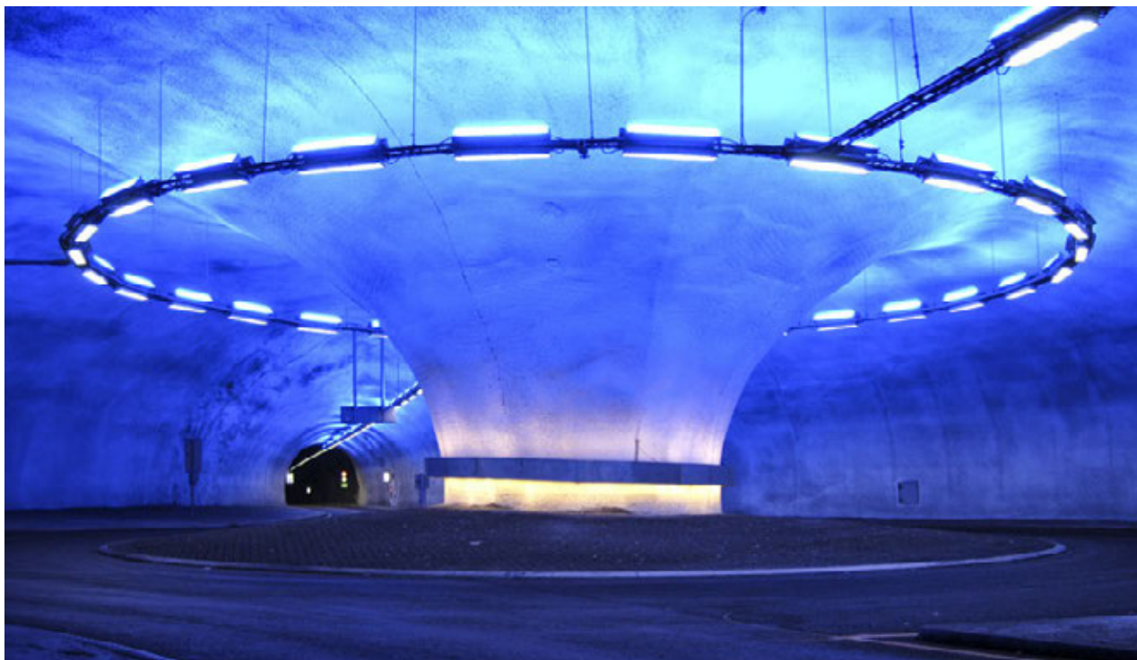
Rundkøyringa i Butunnelen ved Hardangerbrua. Dette riksveganlegget medverkar til regional utvikling i Hordaland. Foto: Geir Brekke, Statens vegvesen
