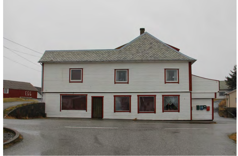
Alfred Børhaug fekk skøyte på denne tomte i 1938 og sette opp forretningsbygg med husvære. Fleire eigarar og leigetakarar dreiv landhandel her fram til 1985. Bygget vart kalla «Filialen» (Skogseth 1997: 79f.)
