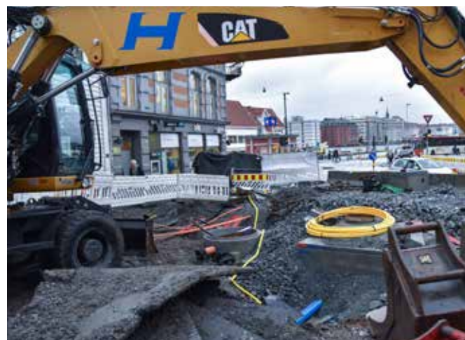
Arbeidet med å rehabilitere Kong Oscars gate startet i 2016. Her fra Vetrilidsallmenningen. Foto: Ingrid Feet Bjørge/Statens vegvesen
