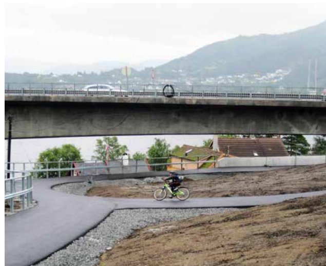
Ny undergang og utbetring av haldeplassar i Fossekrysset, Meland kommune.
