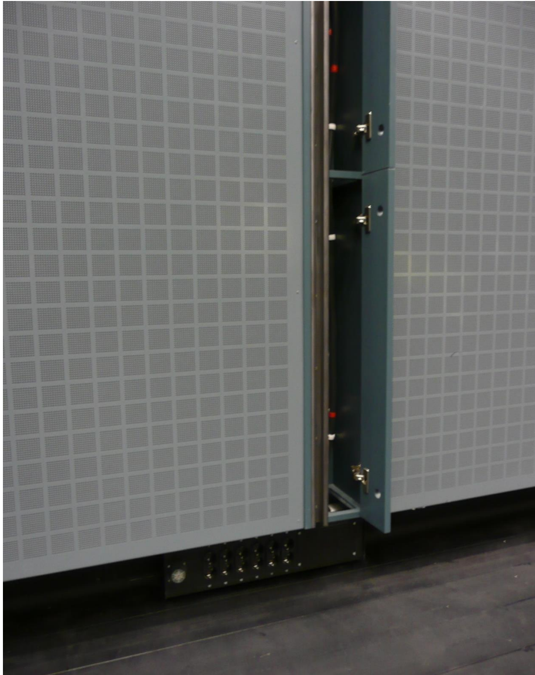
Figur D.4.1.6 Exempel på ankarskinne och uttagsenhet
