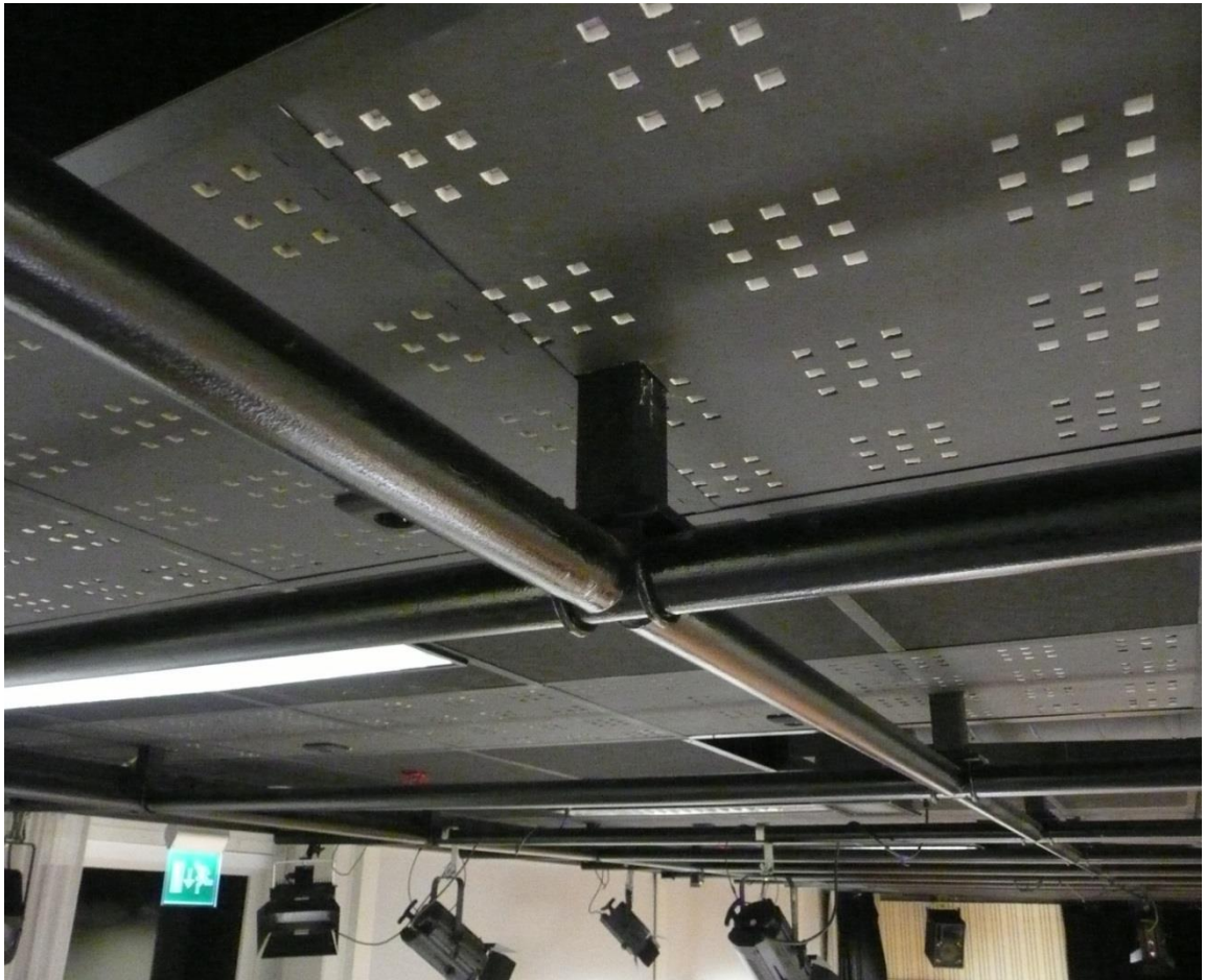
Figur D.4.1.5 Exempel på prøvesal med grid i tak
