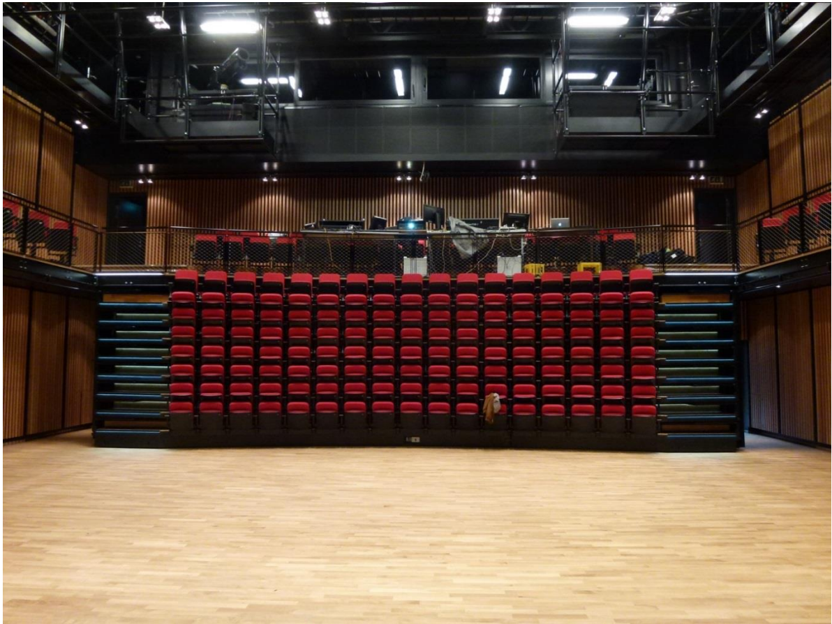
Figur D.4.1.4 Exempel på inskjuten teleskoptribun
