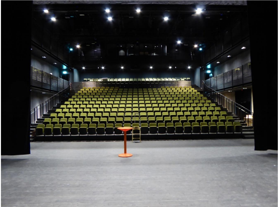
Figur D.4.1.3 Exempel på utdragen teleskoptribun
