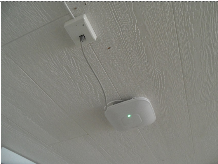
Bilde 4.27: Aksesspunkt for WiFi og trådløs nettverk. Plassert i arealene rundt ekspedisjonen i 1.etg.
