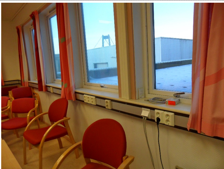
Bilde 4.6: Det er generelt tilfredsstillende antall stikkontakter på bygget.
