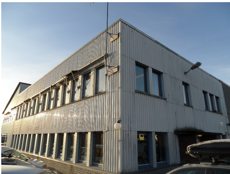
Bilde 4.32: Utendørs eldre belysning i tilknytning til inngangsparti. Enøk styring i form av fotocelle.
