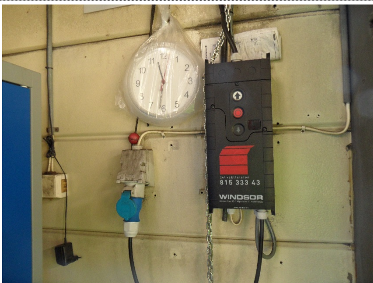
Bilde 4.15: Bryterpanel for motorstyring av garasjeporter.
