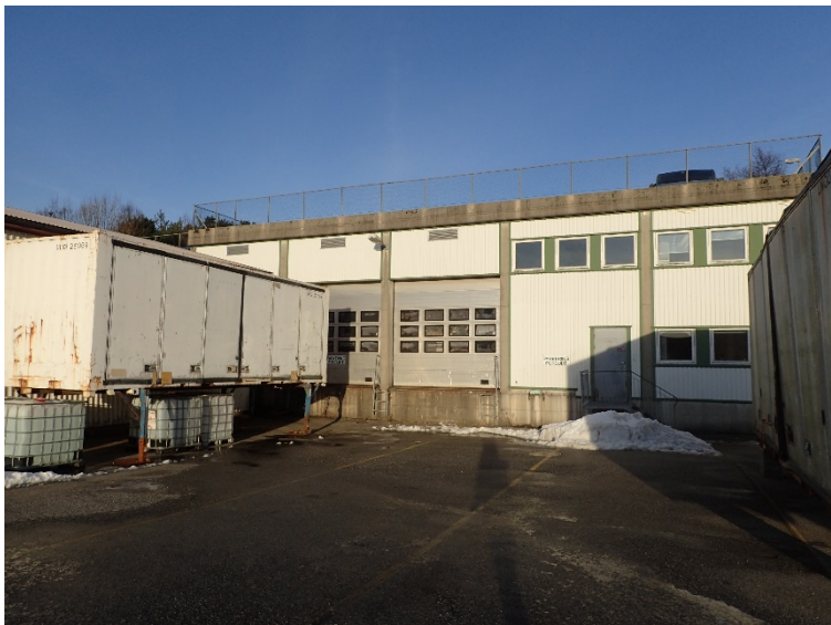
Bilde 2.4: Fasade mot sør.
