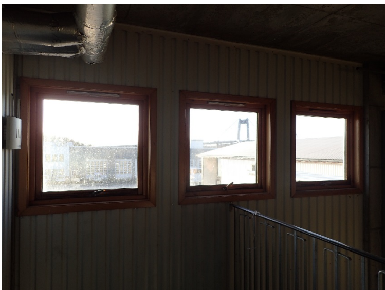
Bilde 2.10: Vinduer i øvre del av lagerrom.
