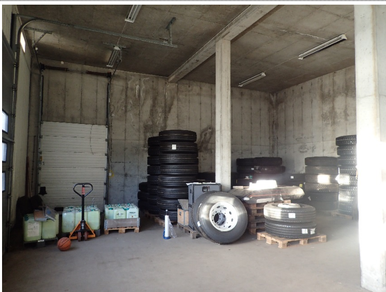
Bilde 2.6: Uisolert lagerrom har vegger og søyler i betong.
