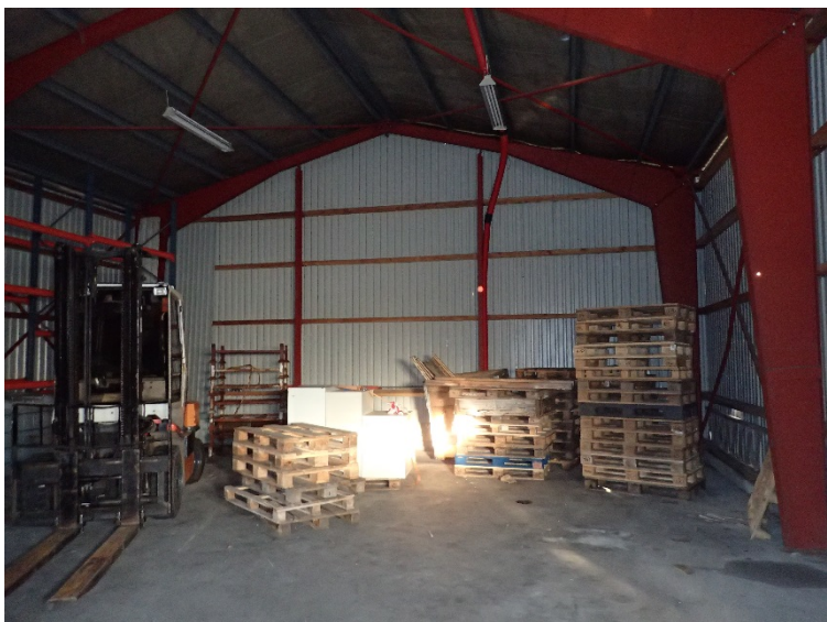
Bilde 2.5: Stålhall med uisolerte yttervegger av bindingsverk og utvendig stålplatekledning.
