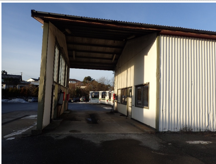
Bilde 2.2: Fasade mot sør, og deler mot øst.
