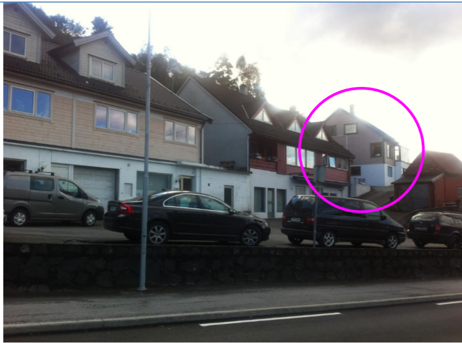
Figur 30 Aktuelle eigedom med dagens hus utheva med rosa sirkel. Dagens bygning på tomte er 3 etg med mønehøgd på ca kote +24moh
