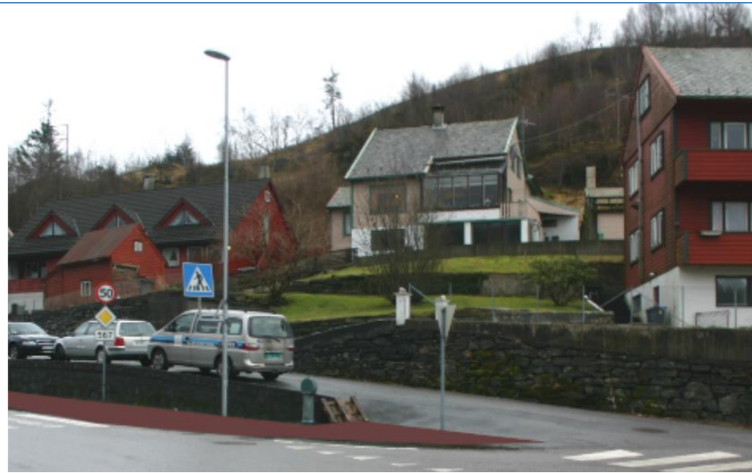
Figur 32 Eksisterande situasjon for BBB02 sett forfra (midt i bildet). Eiedomen ligg høgare i terrenget enn naboegedomane til venstre i bildet. Planframlegg (maks mønehøgd kote +28) opnar for eit fire meter høgare bygg enn dagens situasjon, total 4. etg over bakkenivå
