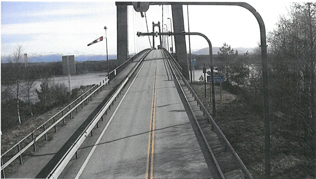
Bomstasjonen ved Spissøybrua
