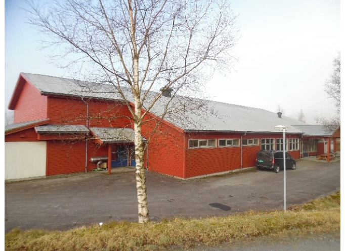
Verkstedbygning fra nord øst.
