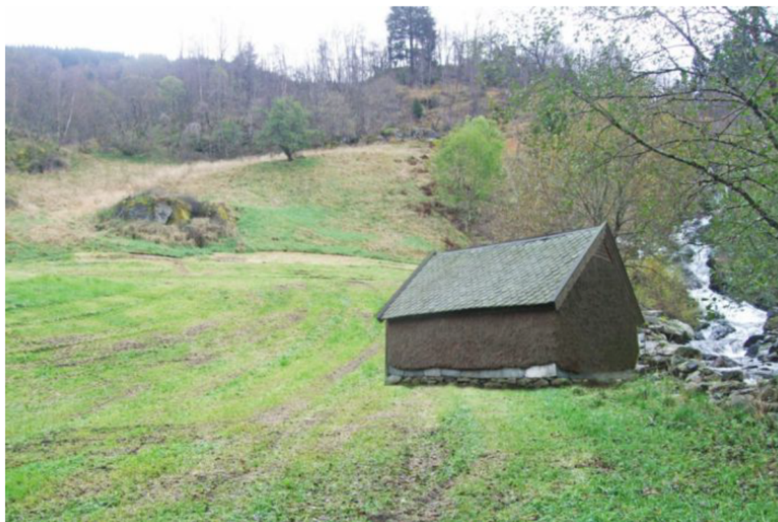
Fig. 6 Kraftstasjonen plassert i terrenget. Gjerstadfossen til høgre.
