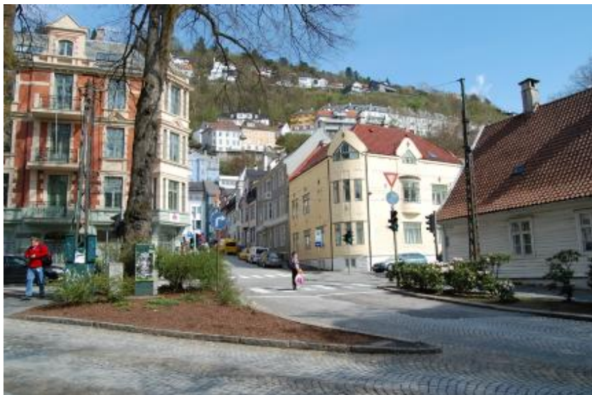
Miljøet sett fra sørvest
