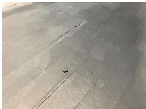
Scenegulvet er så slitt at det ikke er tilrådelig å bruke det før skaden er utbedret.
