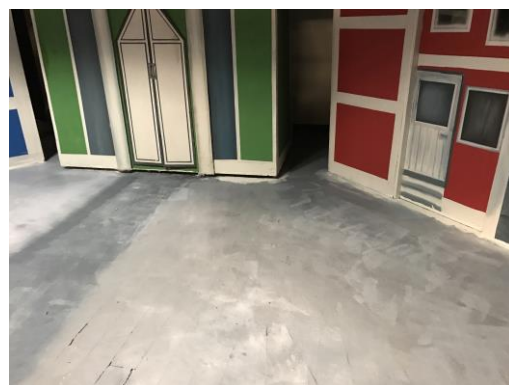
Vinylfliser er løsnet fra gulvspon-platene
