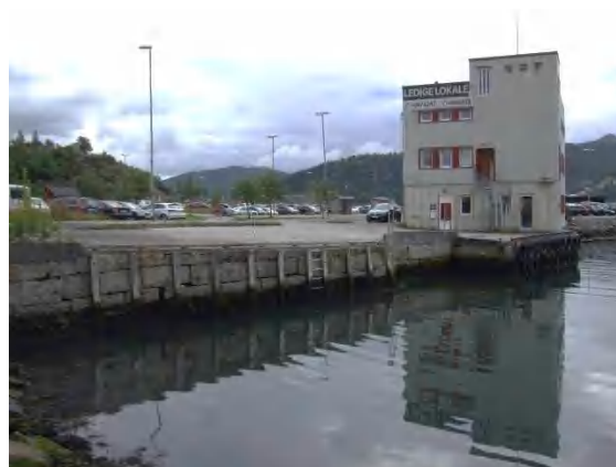
Dampskipskaien med Brekkebygget i dag.
