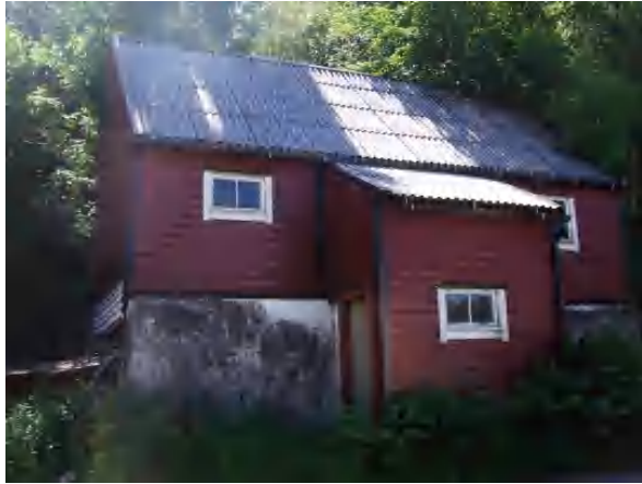
Løe – fasade inn mot tunet
