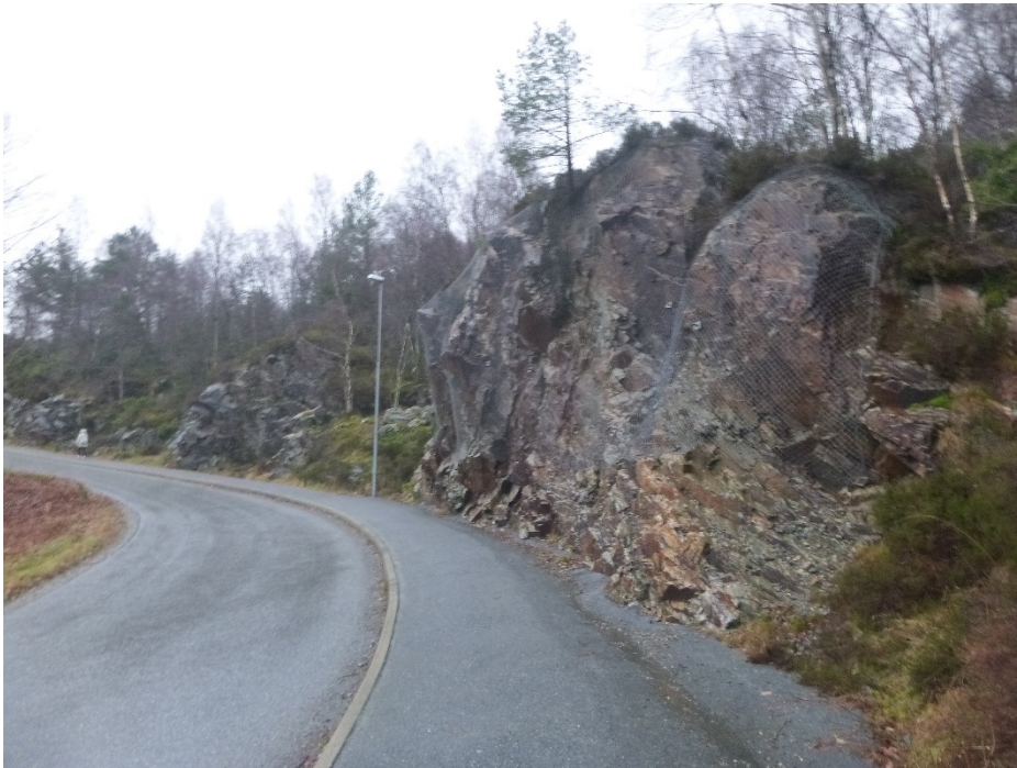
Figur 12 Sikringstiltak gjennomført langs skjæring som ikke er fanget opp av kartet langs Holmedalshammaren.
