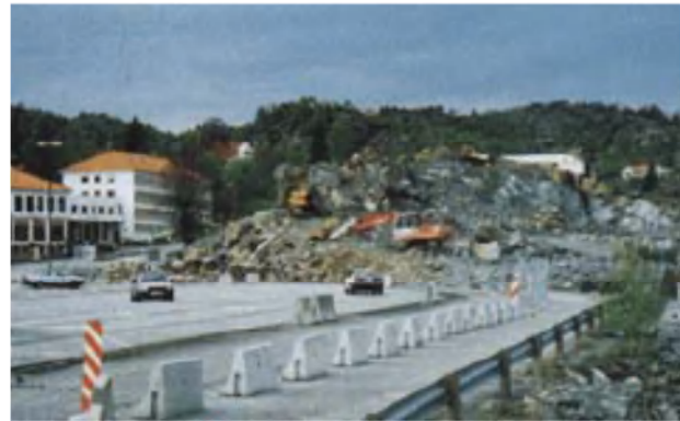
Ny veg – Maltvikhaugen sprenges vekk (1997)
