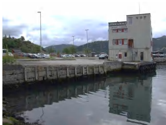
Dampskipskaien med Brekkebygget i dag.
