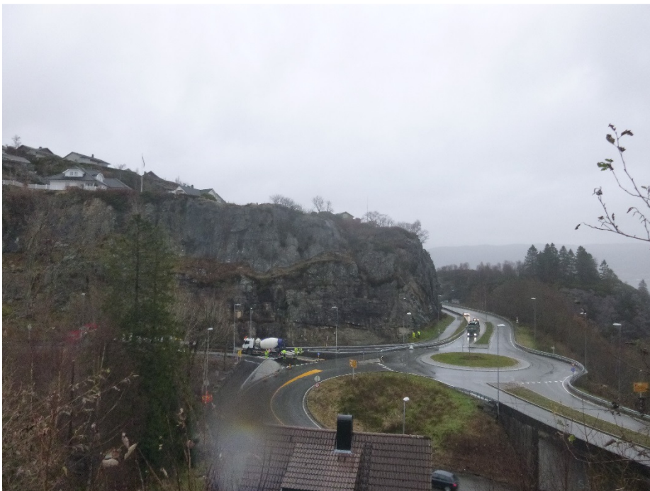
Figur 11 Sikret fjellskjæring ved rundkjøring mellom Klampavikvegen og Stongafjellsvegen.
