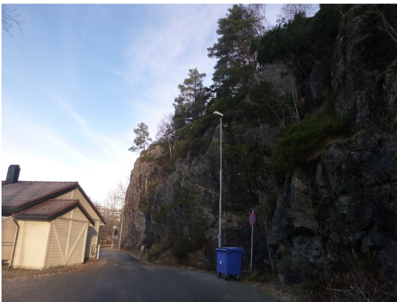
Figur 19 Dalavegen 35 er til venstre i bildet.
