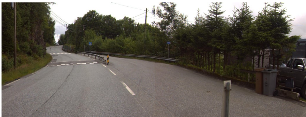
Bilde 1: Vegbilde fra Nasjonal vegdatabank, 13.7.2016. Viser aktuelle avkjørsel fra retning øst.
