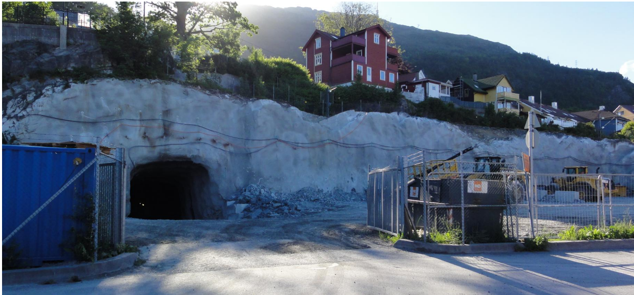
Påhugg for anleggstunnel(Sweco).
