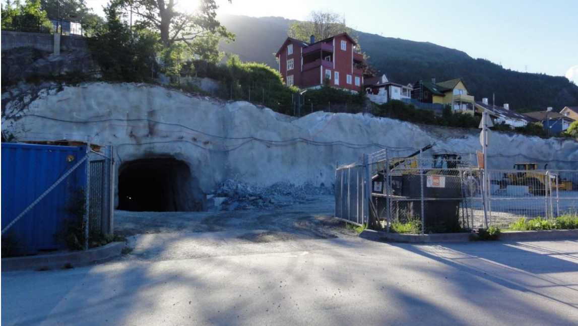
Figur 2: Anleggstunnel og riggområde for Bane NOR i Fløen
